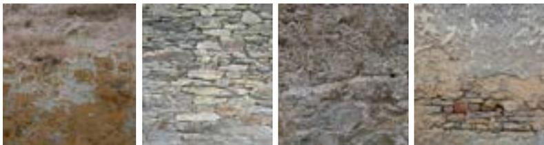
Die häufigsten Schäden entstehen durch den Verfall von Putz und/oder Mörtel, die der Witterung ausgesetzt sind. Stein oder Ziegel sind massiv und solide und müssen nur selten ersetzt werden.
